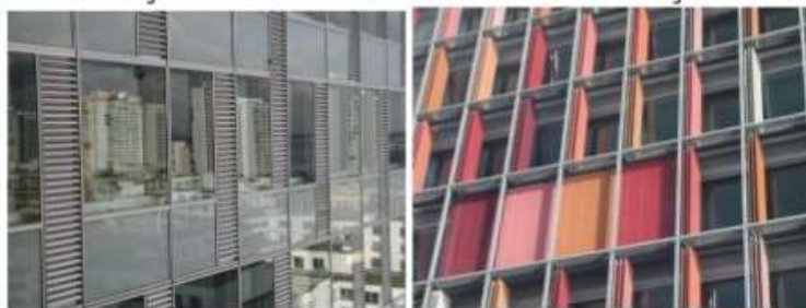
صورة رقم (7) على اليمين الواجهة الغربية للمبنى المزدوجة الطبقات، وعلى اليسار الواجهة الشرقية للمبنى الثلاثية الطبقات. (مرجع رقم " 8 "
